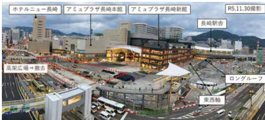
写真3 - 長崎駅東口（国道側）の現状
